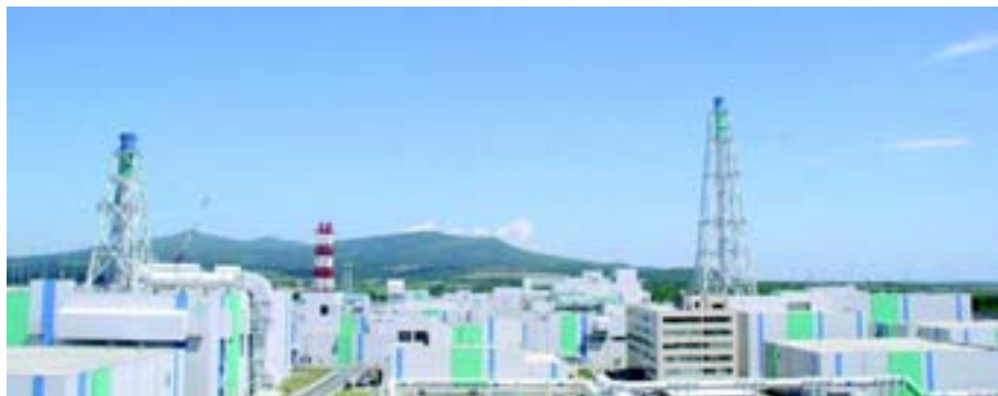
Rokkasho Reprocessing Plant, Rokkasho, Japan (photo courtesy of JNFL).
