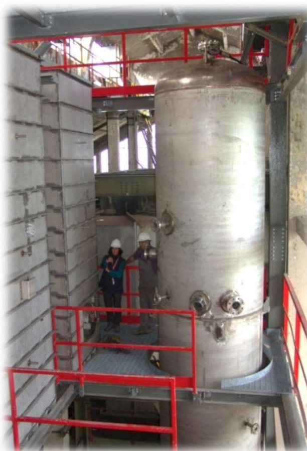
EHRP pools and Drywell
